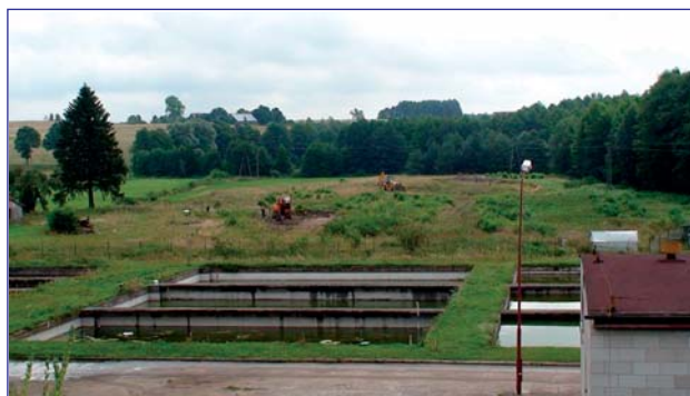
Fot. 2. Początek budowy hali – sierpień 2008.
