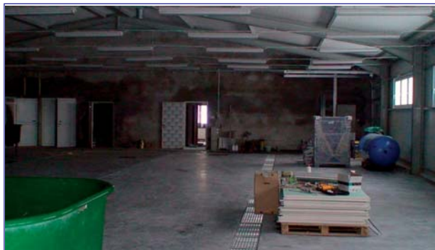
Fot. 5. Montaż urządzeń wewnątrz podchowalni – luty 2009.
