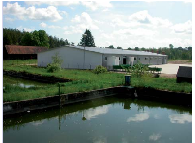
Fot. 7. Nowa hala z zewnątrz.
