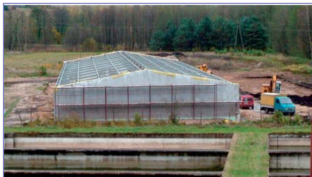
Fot. 4. Zadaszanie hali – październik 2008.
