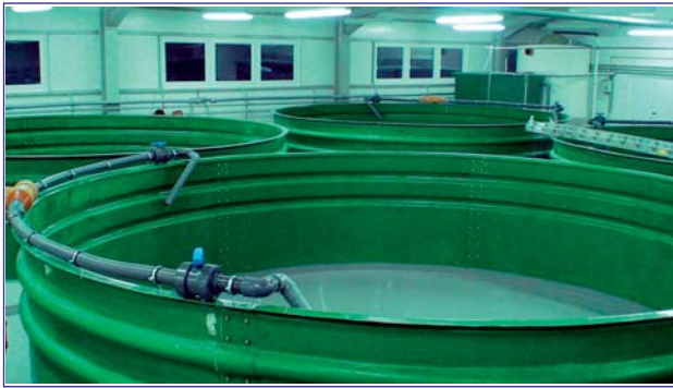
Fot. 6. Montaż basenów dla selektów i tarlaków – kwiecień 2009.
