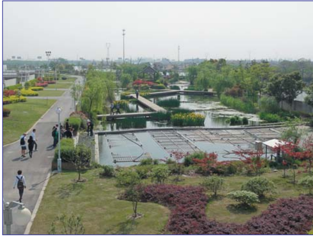
Fot. 5. Ogród chiński przy oczyszczalni ścieków w Wuxi.
