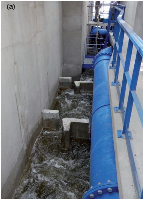
Fot. 3. Nowa przepławka z wodą (a) i bez wody (b).
