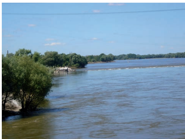
Fot. 2. Próg poniżej stopnia.
