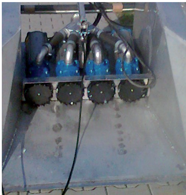
Fot. 3. Widok wlotu osadów do 4 pomp zainstalowanych na dnie szufli zbierającej.
