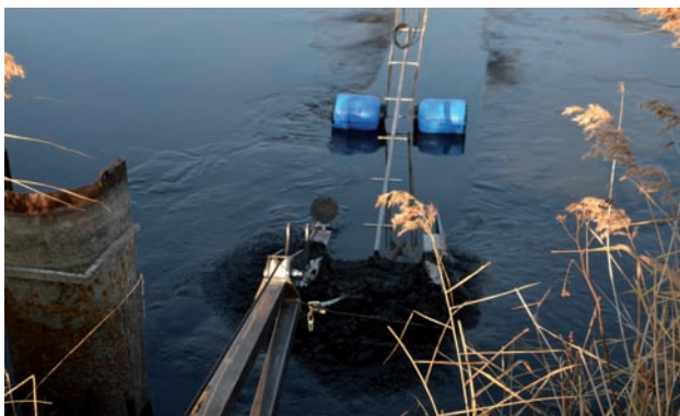
Fot. 2. Przemieszczanie odmularki po dnie rowu.
