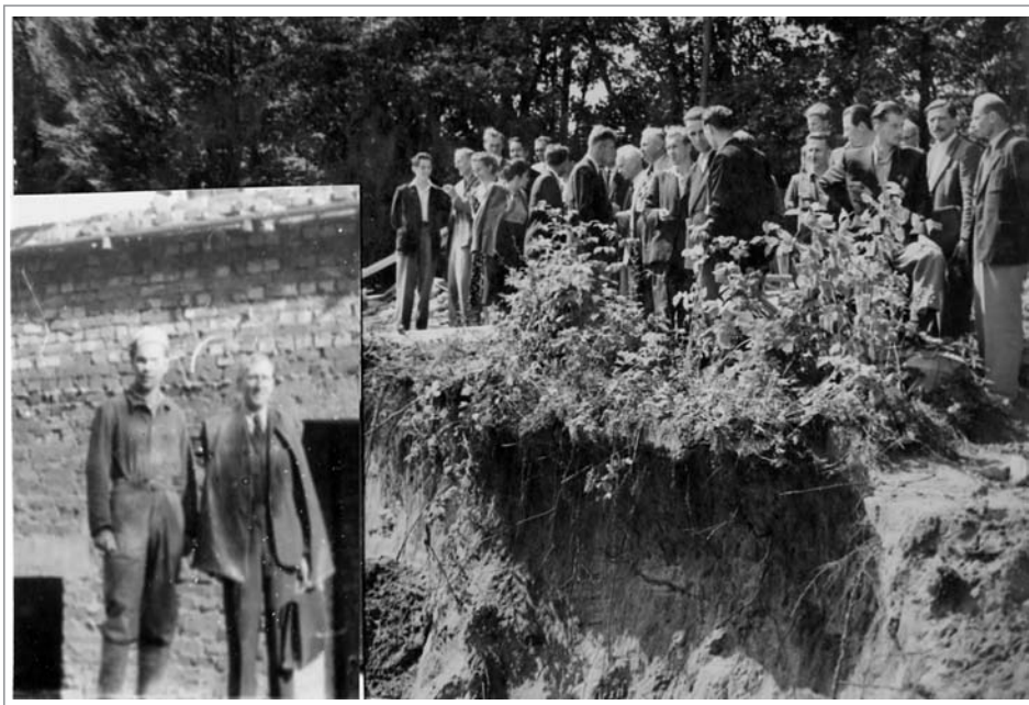
25 VII 1952 r. - tu stanie budynek Instytutu Rybactwa Śródlądowego. Profesor na budowie – zawsze z teczka
