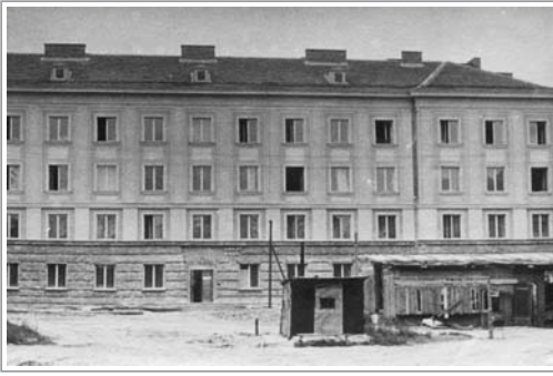
Ostatni etap budowy
