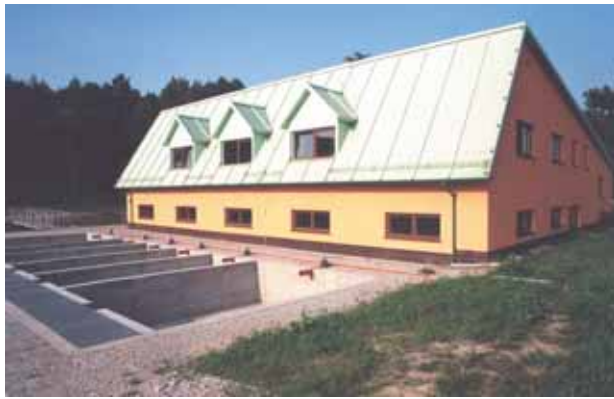
Fot. 1. Nowo wybudowana (kwiecień 2001 r.) wylęgarnia w Ośrodku Zarybieniowym Szczodre
