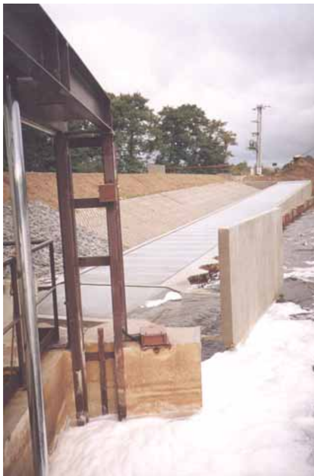
Fot. 1. Widok na nową, techniczną przepławkę przy górnym jazie na Redze w Trzebiatowie. Przepławka jest przykryta metalową, ochronną kratą ażurową.
