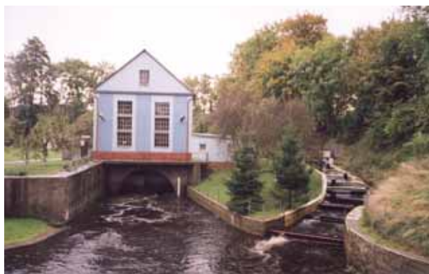
Fot. 2. Okresowo funkcjonująca przepławka przy „starej” elektrowni wodnej w Trzebiatowie.
