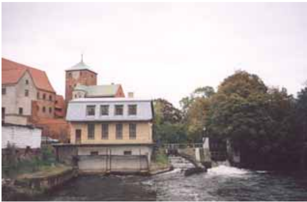
Fot. 3. Tak pomiędzy małym jazem roboczym a elektrownią posadowiona jest przepławka na Wieprzy w Darłowie.
