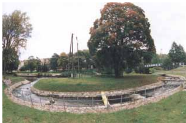
Fot. 5. Ogólny widok przepławki na Słupi. Coś pomiędzy kamienią platformą komorową a typowym obejściem.
