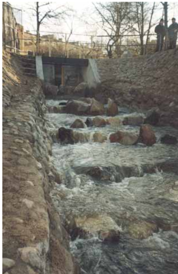
Fot. 4. Kamienne progi basenów przepławki na Wieprzy.
