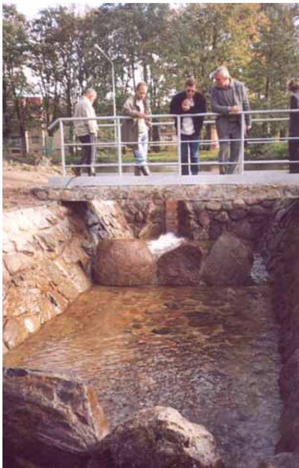
Fot. 6. Wygląd I komory - basenu przepławki na Słupi. Z prawej strony widoczny przesmyk pomiędzy kamieniami progu a bokiem przepławki.
