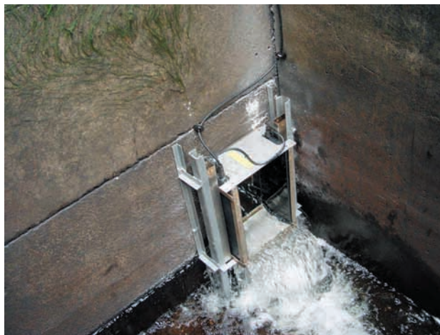
Fot. 3. Zamontowany licznik (przy częściowo zamkniętej wodzie).
