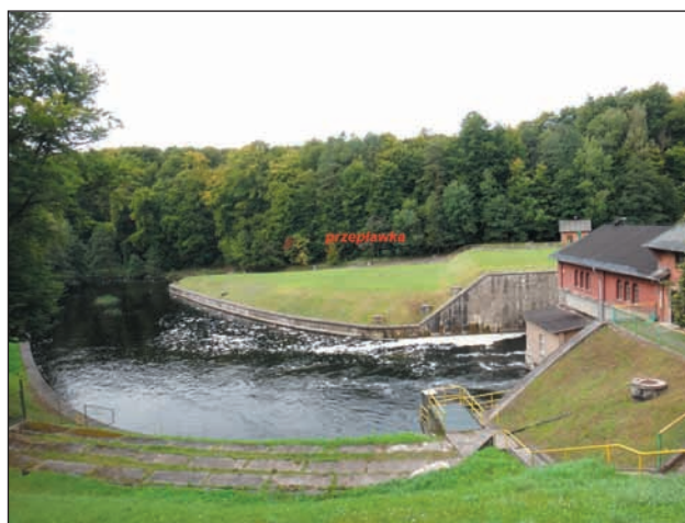
Fot. 1. Widok zapory i elektrowni.
