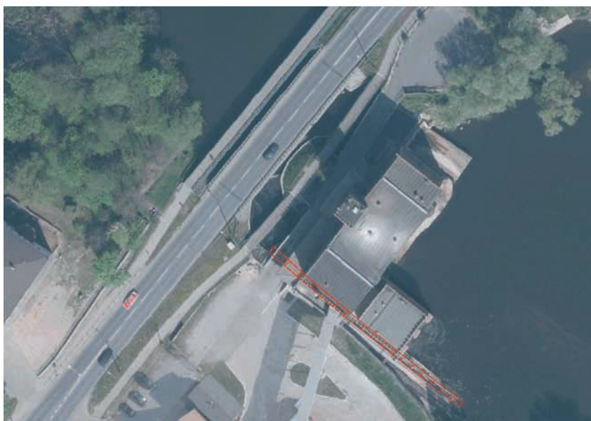
Rys. 1. Usytuowanie przepławki na rz. Wdzie w Świeciu-Przechowie.
