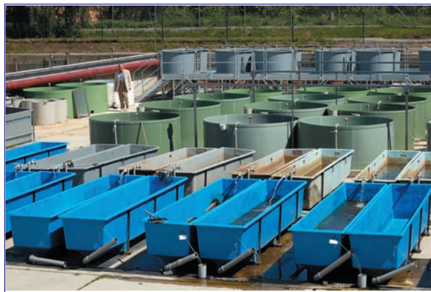
Fot. 2. Nowo wybudowany kompleks basenowych systemów recykulacyjnych.
