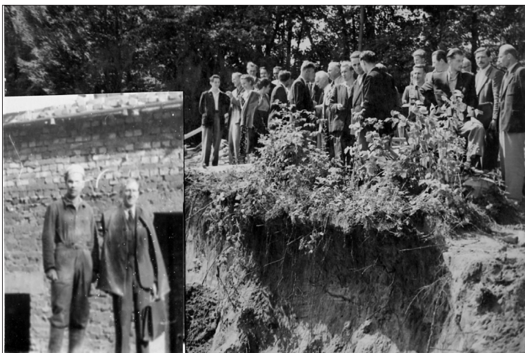
Fot. 2. 25 VII 1952 r. - tu stanie budynek Instytutu Rybactwa Śródlądowego. Profesor na budowie – zawsze z teczka
