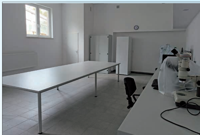
Fot. 2. Laboratorium biologiczne po remoncie.
