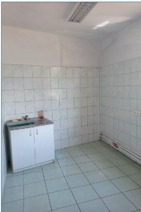
Fot. 3 Laboratorium chemiczne przed remontem.
