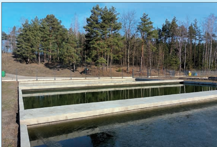
Fot. 6 Stawy betonowe po renowacji.
