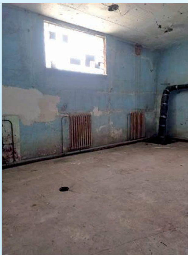
Fot. 1. Laboratorium biologiczne przed remontem.
