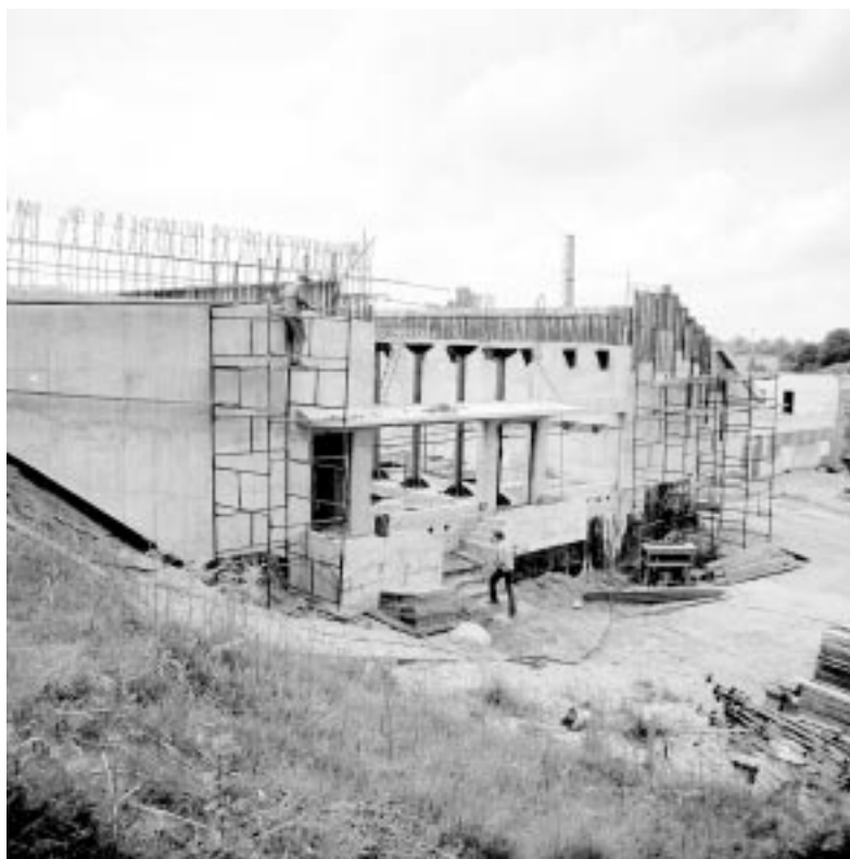
Budowa Pracowni Hodowli Ryb Łososiowatych w Rutkach
